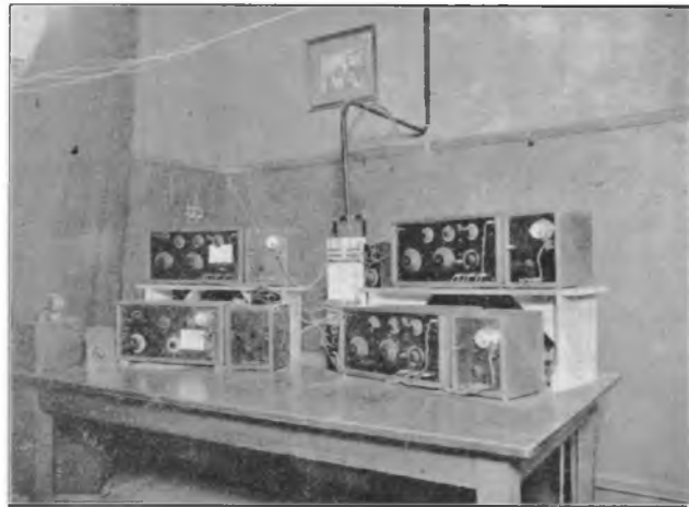
Fig. 7. Ontvang-toestellen van de Gemeentelijke Radio-Centrale te Den Haag
